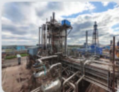
Usine de production d'ammoniac
